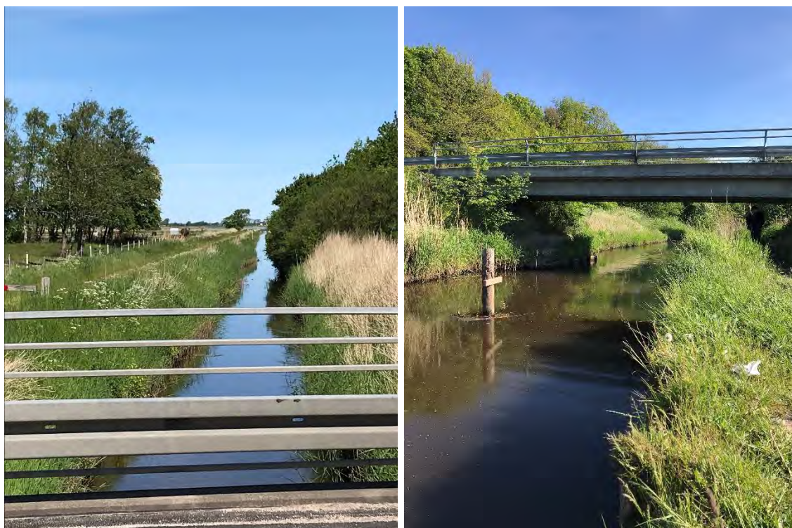
Figur 5-1 Hasseris Å (th.) syd for Limfjorden ved Nørholmsvej, og Lindholm Å (tv.) nord for Limfjorden ved Søndergårdsvej.
